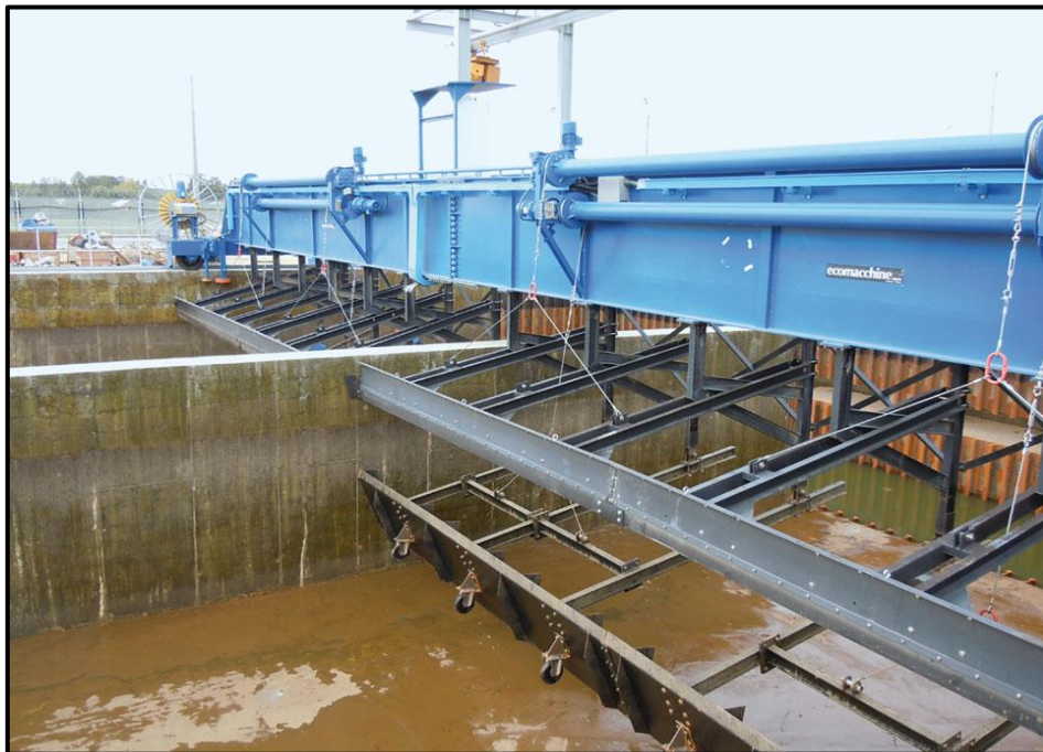
شکل ۴-۱۵- لجن‌روب پارویی با پل رفت و برگشتی ۱
